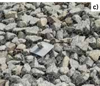
Rys. 9. Zabezpieczenia obszaru osuwiskowego przy południowym portalu tuneli (strona wschodnia): a) wysoka palisada rozmieszczona schodkowo b) mur oporowy i kamienny zasyp c) głowica głębokich kotwi gruntowych
