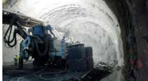
Rys. 3. Wiercenie otworów dla nadstropowego wachlarza kotwi (obudowa parasolowa) [5]
