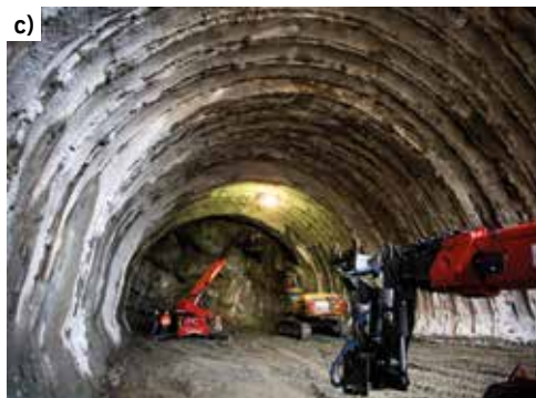
Rys. 5. Obudowa wstępna: a) instalacja żeber obudowy wstępnej [5] b) torkretowanie [5] c) widok ogólny [GDDKiA]
