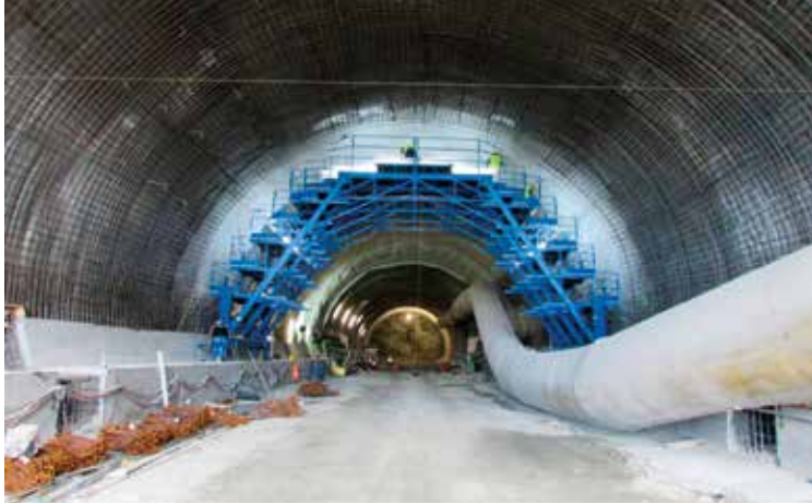
Rys. 6. Wykonawstwo żelbetowej obudowy ostatecznej: z lewej – przestawne rusztowanie do montażu zbrojenia [GDDKiA], z prawej – deskowanie do zabudowy betonu [GDDKiA]
