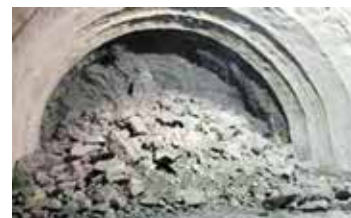
Rys. 4. Czoło przodka, z lewej: opróżnianie strefy przodka z urobku [5] z prawej: hałda urobku po odstrzale [GDDKiA]
