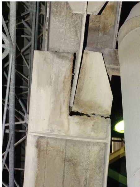
Rys. 2. Zerwane połączenie rozciąganego pręta stężenia i jego obraz z chmury punktów
