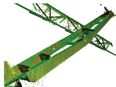
Rys. 1. Wybożony krzyżulec i jego obraz w obrabiałej graficznie chmurze punktów
