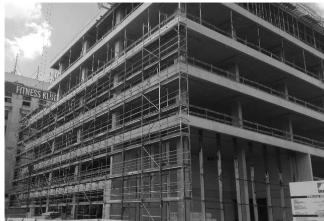
Rys. 2. Widok rusztowania Fig. 2. View of the scaffolding
