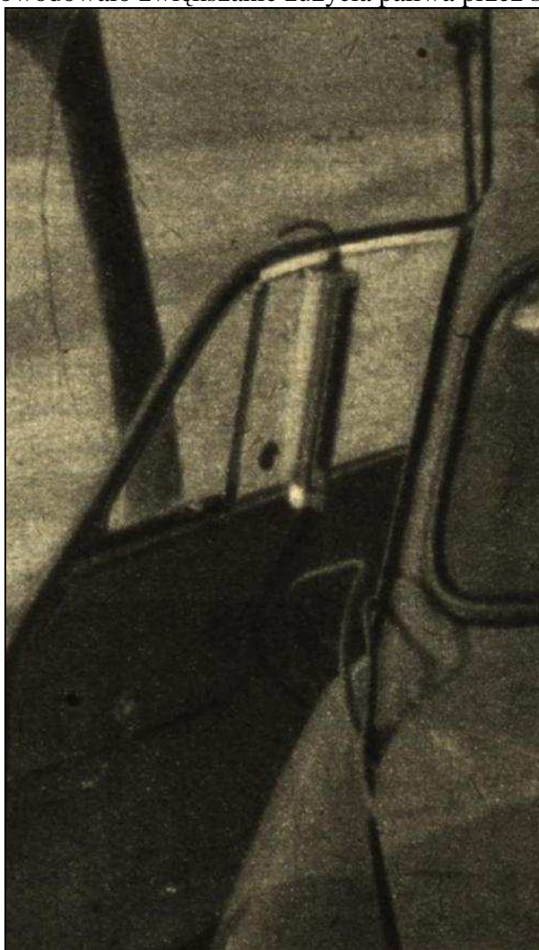
Fot. 5. Aparatura do badania zużycia paliwa była mocowana na drzwiach badanego samochodu [6]
