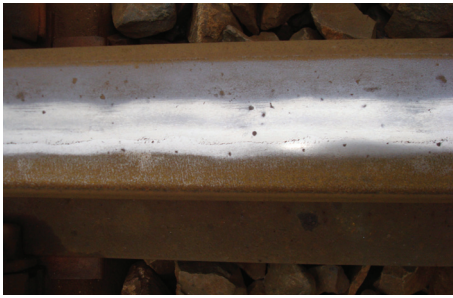
Rys. 1. Wgnioty po zgorzelinie na powierzchni szyny
