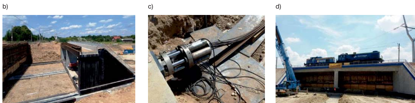
Fot. 11. Wiadukt kolejowy WD-6: a) pierwotna koncepcja wiaduktu, b) naciąganie ramy żelbetowej dwunawowej, c) urządzenie naciągowe, d) próbne obciążenie (fot. inż. Radosław Wróbel)
