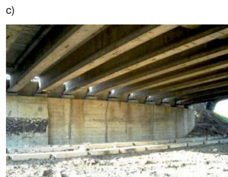
Fot. 1. Belki prefabrykowane systemu: a) Gromnik - Dąbrowica, rzeka Łazęga, ukos prawy 45°, b) Płońsk - Puławy, uciążlony wiadukt nad koleją, c) WBS - Chełm – remont wiaduktu nad koleją
