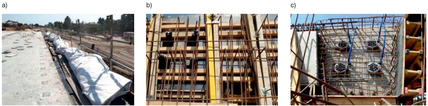
Fot. 8. Fazy budowy ustroju nośnego: a) geowłókninę stosowano jako warstwę pielęgnacyjną, b) wypuszczone końcówki splotów sprężających, c) bloki kotwiące przygotowane do zabetonowania w ścianie zapleczej
