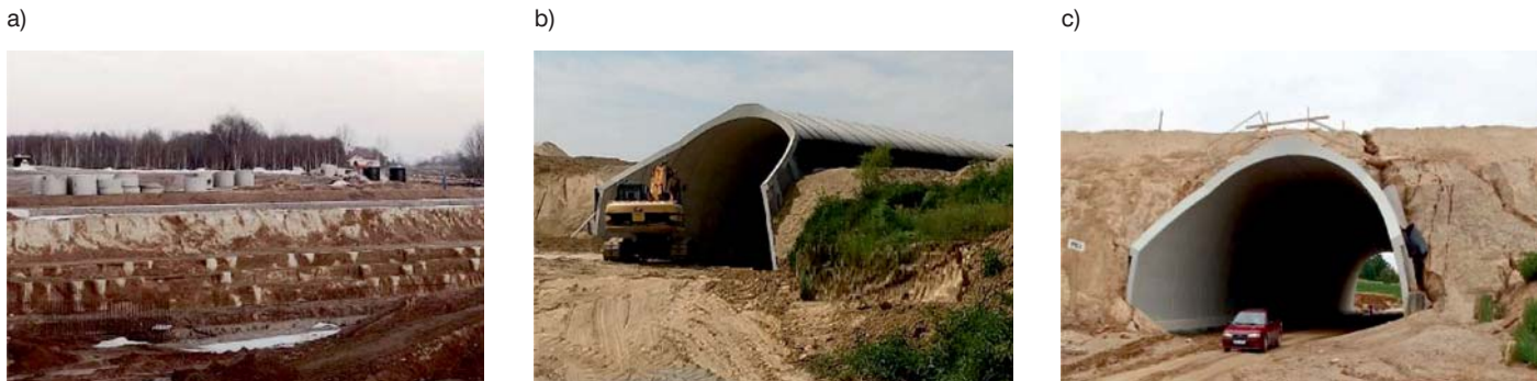
Fot. 10. Przepust betonowy Techspan: a) stabilizacja i wzmocnienie gruntu w sąsiedztwie przejazdu, b) pośrednia faza budowy, c) stan końcowy
