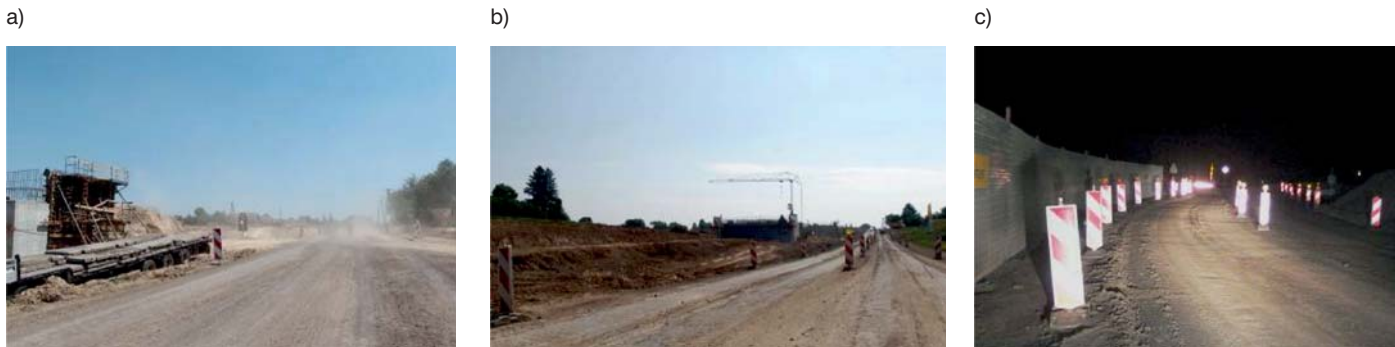
Fot. 5. Utrzymanie drogi objazdowej: a) zapylenie powietrza w dni pogodne, b) błoto lessowe w dni deszczowe, c) pionowe oznakowanie jezdni nocą
