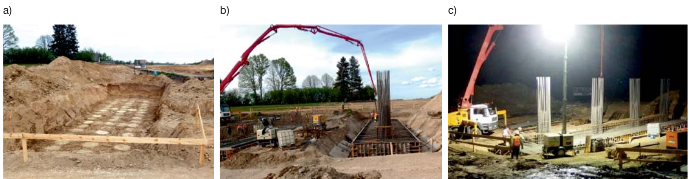
Fot. 2. Prace fundamentowe: a) układ kolumn pod przyczółkiem, b) prace zbrojarskie, c) betonowanie w nocy
