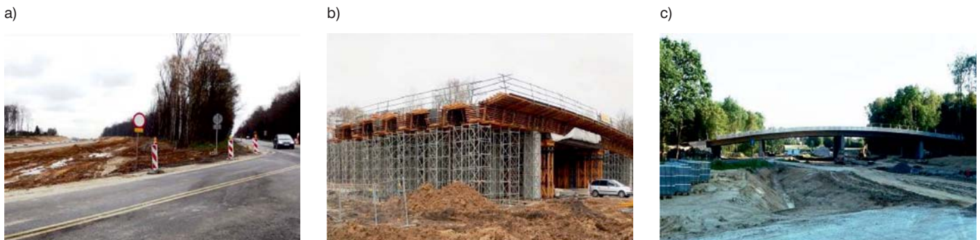
Fot. 9. Górne przejście dla zwierząt: a) obszar objęty wycinką lasu, b) przekrój poprzeczny wiaduktu, c) widok z boku
