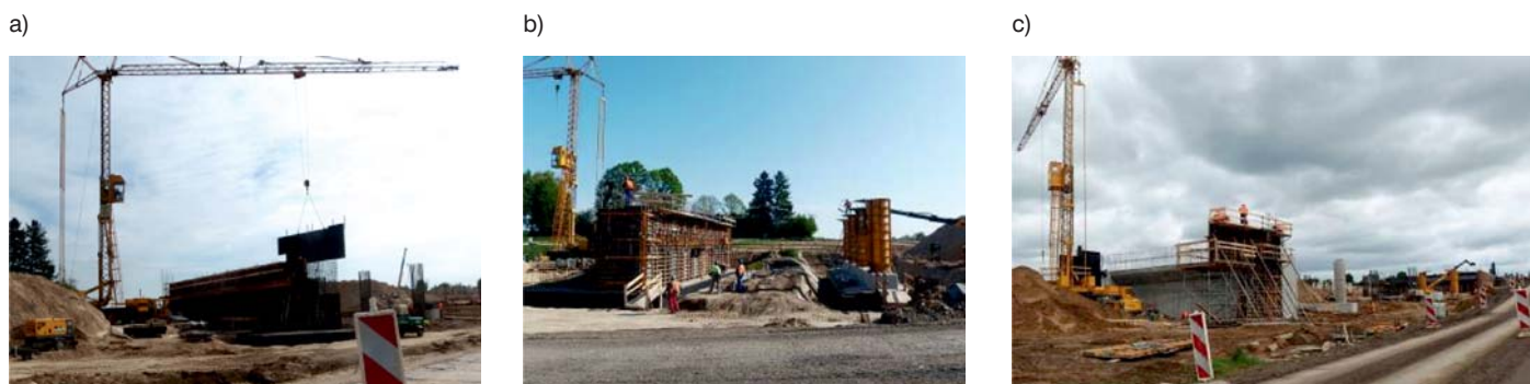
Fot. 3. Prace deskowaniowe: a) na przyczółku, b) przy filarach, c) rozdeskowywanie
