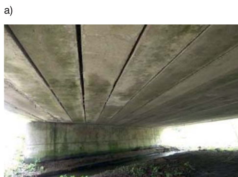
Fot. 1. Belki prefabrykowane systemu: a) Gromnik - Dąbrowica, rzeka Łazęga, ukos prawy 45°, b) Płońsk - Puławy, uciążlony wiadukt nad koleją, c) WBS - Chełm – remont wiaduktu nad koleją
