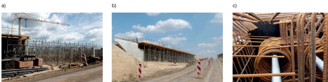
Fot. 6. Deskowanie ustroju nośnego: a) i b) podparcie ciągłe deskowań ustroju nośnego i postęp robót, c) zbrojenie stref zakotwień kabli sprężających
