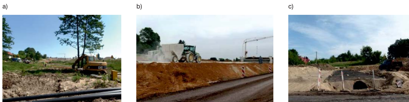
Fot. 4. Roboty towarzyszące: a) przełożenie przewodów prowadzących media, b) budowa nasypu dojazdowego, c) przepust, element odwodnienia przy wiadukcie
