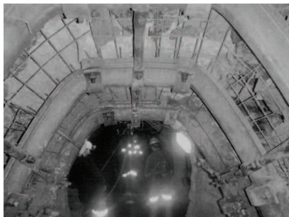
Rys.5. Obudowa chodnikowa typu ŁPrP/4 [8]
