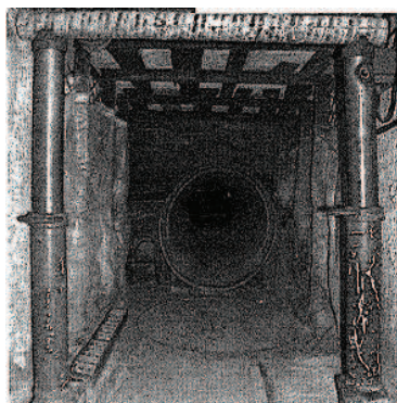
Rys. 2. Odrzwia obudowy chodnika ratowniczego ze stojakami RSH-1 [3]
