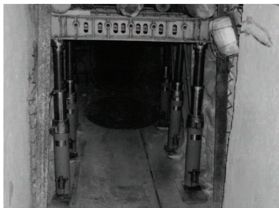
Rys. 6. Obudowa chodnikowa typu KR-7,8 zabudowana w chodniku [8]
