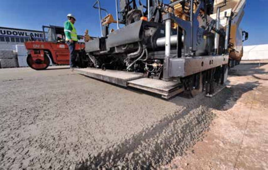
Zagęszczanie mieszanki betonowej
