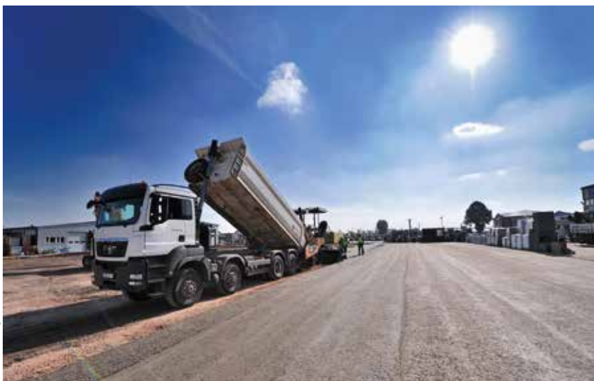
Transport i rozładunek mieszanki betonowej
