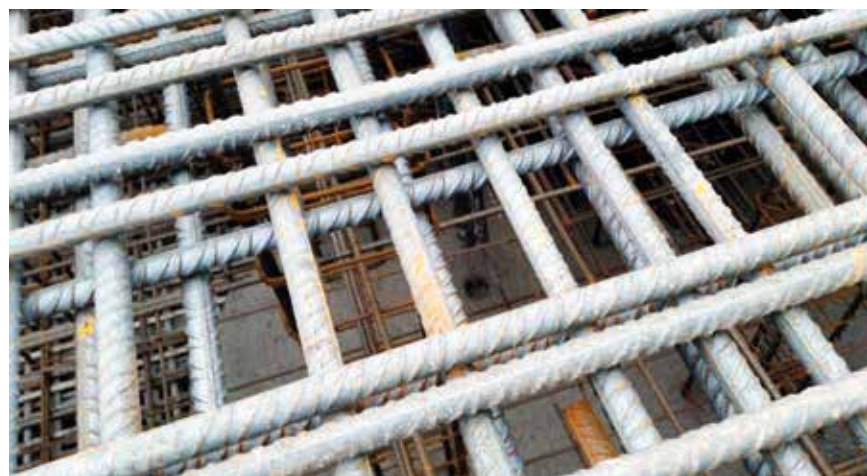
Fot. 1. Konieczność przygotowania miejsc do wprowadzenia węża pompy
