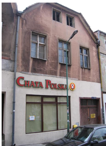
Rys. 1. Kozuchów ul. 1 Maja 7, elewacja północna
