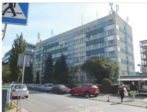
Fot. 22. Budynek OBR MHiR – stan aktualny. [9]
