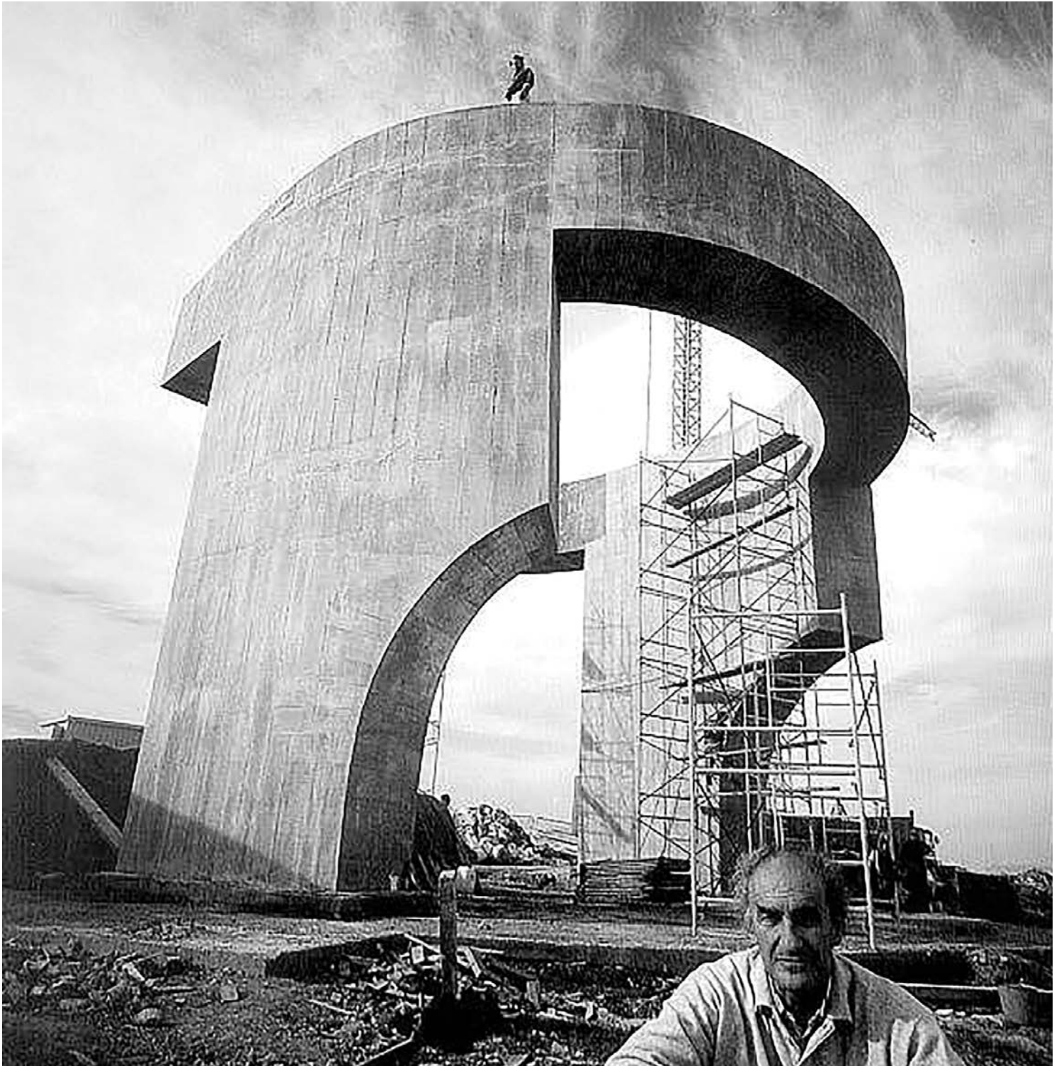
II. 1. Eduardo Chillida podczas budowy „Pochwały horyzontu” (Gijón, 1990)
