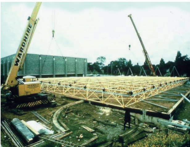
Il. 6. Nodus Centre (Uniwersytet w Surrey) w trakcie budowy, 1972 (źródło: Space Structures Research Centre Archives, University of Surrey)
