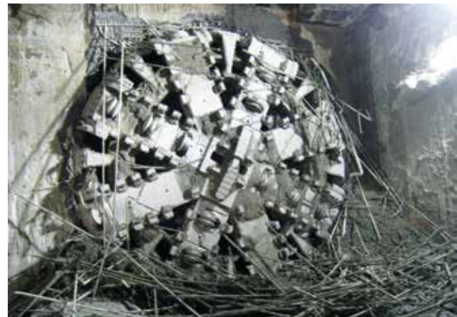
Rys. 2. Głowica skrawająca maszyny TBM po przewierceniu się przez ścianę szczelinową stacji (fot. autor)
