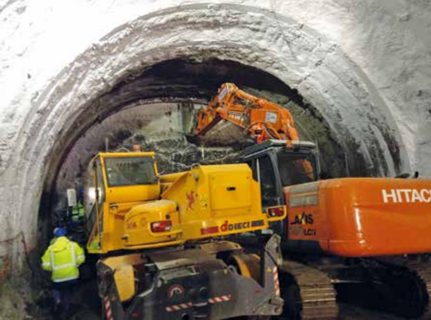
Rys. 7. Tunel łącznikowy na stacji „Centrum Nauki Kopernik” – drążenie w zamrożonym gruncie (fot. autor)
