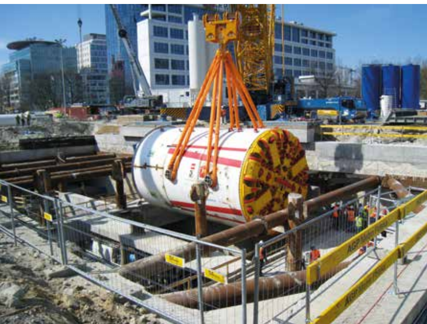
Rys. 8. Tarcza „Maria” w momencie opuszczania na dno szybu startowego – stacji „Rondo Daszyńskiego” (fot. autor)
