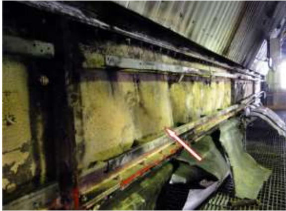
Rys. 5. Znaczące deformacje o maksymalnej strzałce 26 mm w obszarze segmentu 4E obudowy przenośnika od strony wschodniej filtru [1].
