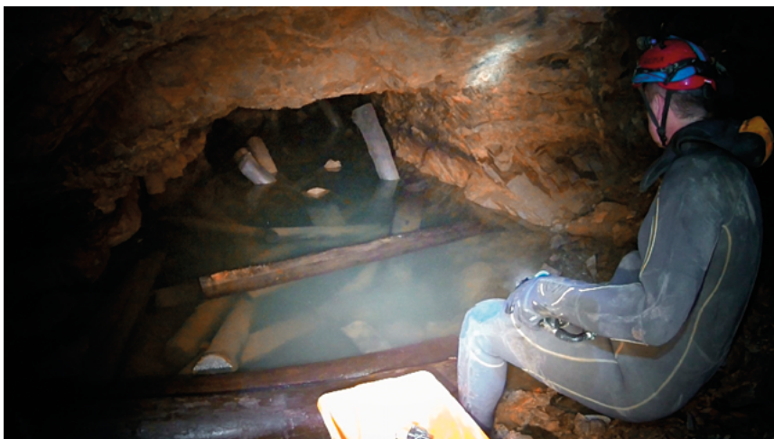
Ryc. 5. Zniszczona obudowa sztolni nr 2, 2019 r. (fot. M. Stysz)
