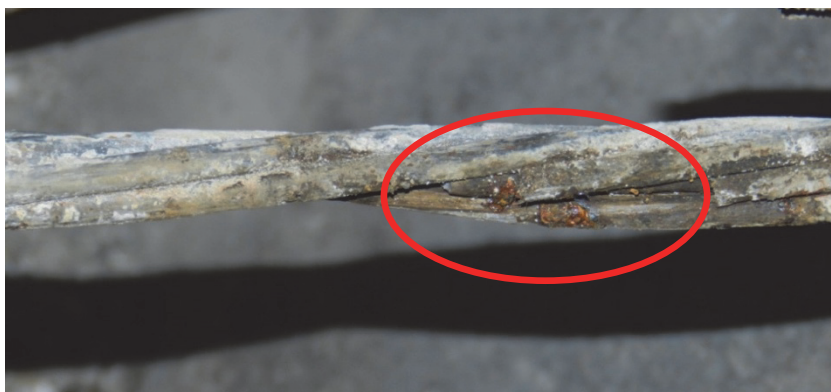
Rys. 4. Wżery korozyjne na drutach splotu
