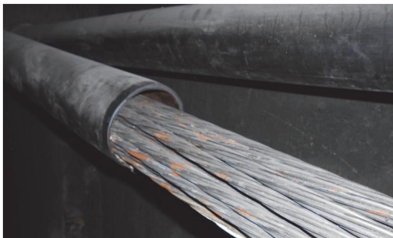
Rys. 6. Fragment kabla bez wypełnienia iniektem.
