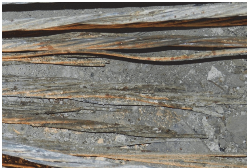
Rys. 5. Zerwane pojedyncze sploty
