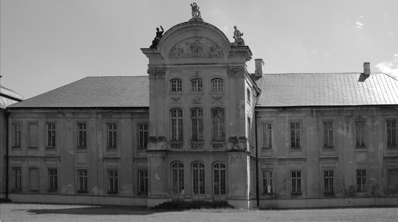
Ryc. 5. Fasada ogrodowa pałacu. Fot. M. Królikowska-Dziubecka
