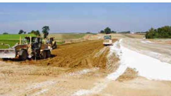
Grunt przed i po stabilizacji wapnem
