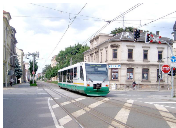
Rys. 13. Trójszynowe torowisko w centrum Zwickau zastosowane w celu umożliwienia poruszania się po nim pojazdów szynowych przystosowanych do różnej szerokości toru (1000 mm dla tramwaju i 1435 mm dla autobusu szynowego RegioSprinter) [22]
