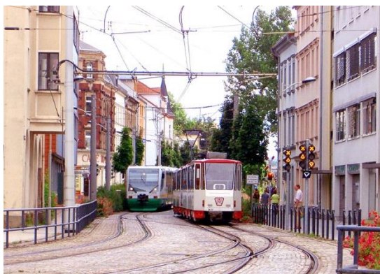
Rys. 14. Układ torowy wraz ze skomplikowanymi rozwiązaniami rozjazdów w centrum Zwickau zastosowanymi w celu umożliwienia poruszania się po nim pojazdów szynowych przystosowanych do różnej szerokości toru (1000 mm dla tramwaju i 1435 mm dla autobusu szynowego RegioSprinter) [3]
