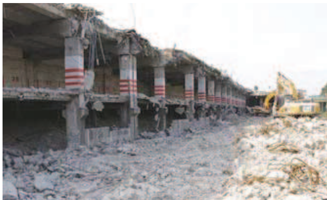
Rys. 3. Rozbiórka konstrukcji parkingu w rejonie Ronda Kaponiera w Poznaniu
