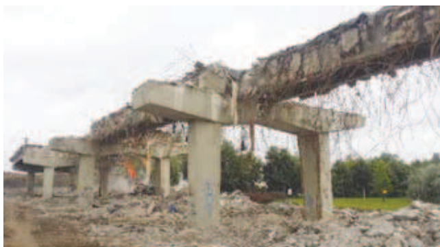
Rys. 1. Rozbiórka skrajnej konstrukcji estakady w ciągu ul. Bolesława Krzywoustego w Poznaniu
