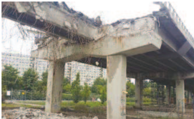
Rys. 2. Rozbiórka środkowej konstrukcji estakady w ciągu ul. Bolesława Krzywoustego w Poznaniu
