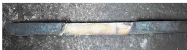
Fot. 3. Odspojenie fragmentu nakładki stykowej wynikające z niewłaściwego procesu wytwarzania ślizgacza
