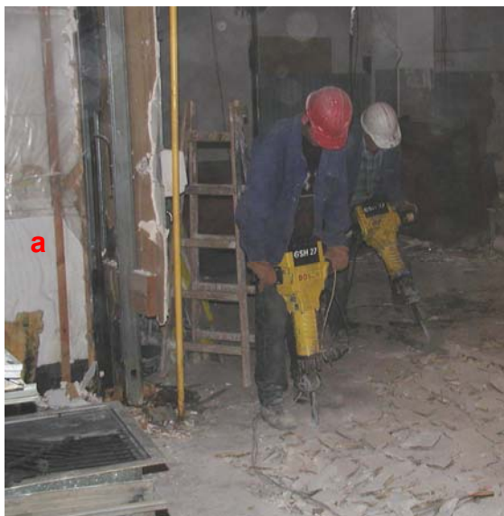
Fot. 1. Skuwanie podłogi z użyciem młotów pneumatycznych, w pomieszczeniu z osłoniętymi folią wyrobami z azbestem (oznaczonymi jako „a”)
