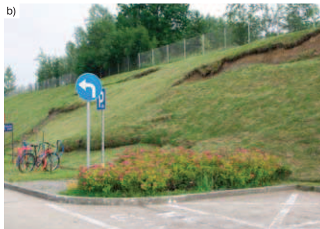
Rys. 1a, 1b. Przykładowe awarie konstrukcji inżynierskich – nasypów, ciągów komunikacyjnych na terenach osuwiskowych [5]
