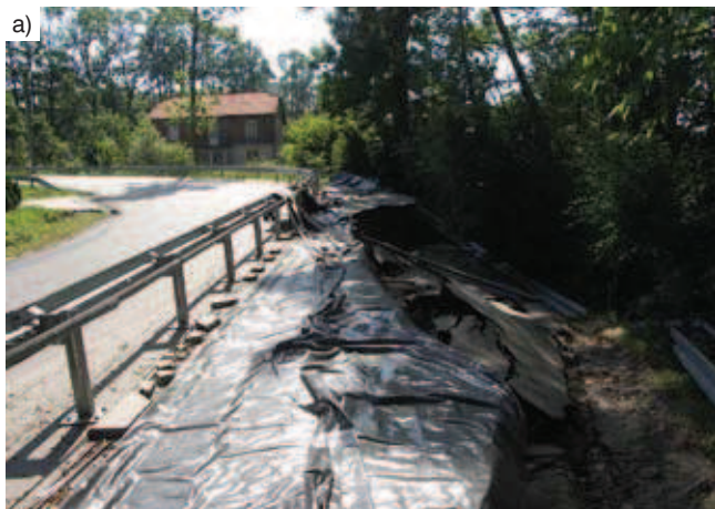
Rys. 1a, 1b. Przykładowe awarie konstrukcji inżynierskich – nasypów, ciągów komunikacyjnych na terenach osuwiskowych [5]
