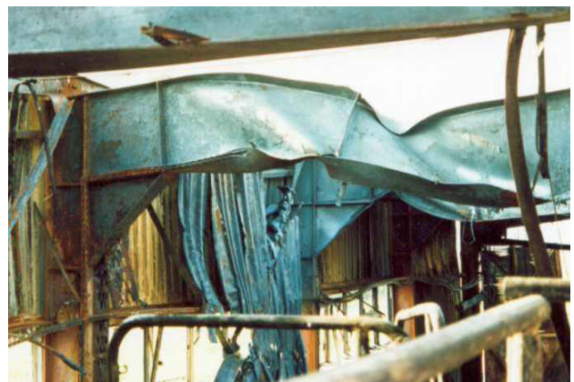
Ryc. 3. Przestrzenne deformacje termiczne rygli ramy z profili IPN 400 (hala 1) [1]
