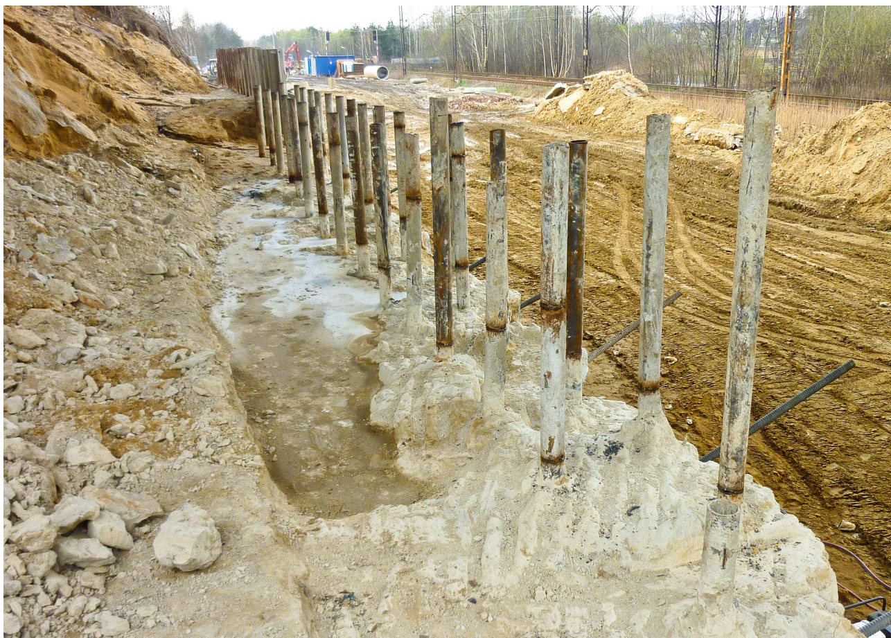
Rys. 5. Wykonana palisada oporowa podtrzymująca skarpe przyczółku wiaduktu w Żorach z widocznym zbrojeniem rurowym przed zabetonowaniem oczepu (fot. własna)
