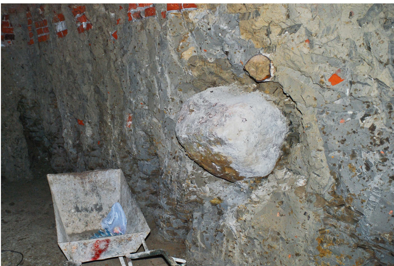
Rys. 4. Głaz narzutowy zalegający w podłożu, w strukturze kolumn tworzących podchwyconie iniekcyjne kamienicy w Alejach Jerozolimskich w Warszawie (fot. własna)
