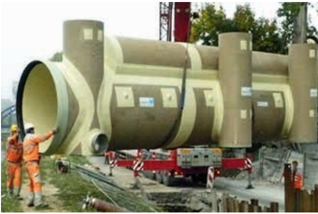
Montaż zbiornika, Bańska Bystrzyca, Słowacja (DN 2000/DN 1400)
