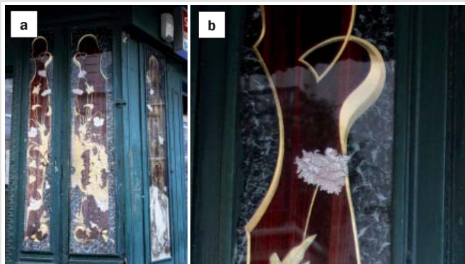
Fot. 11 a, b. Fragment i detal elewacji restauracji ozdobionej szklanymi panelami zdobionymi techniką rytowania i egłomizacji, Paryż, Francja, źródło: Wikimedia.
