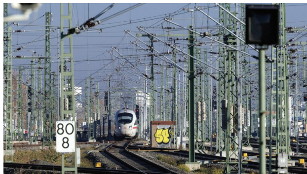
Rys. 2. Przy rozwiniętej infrastrukturze linii kolejowych łatwo o naruszenie skrajni budowli [3]
