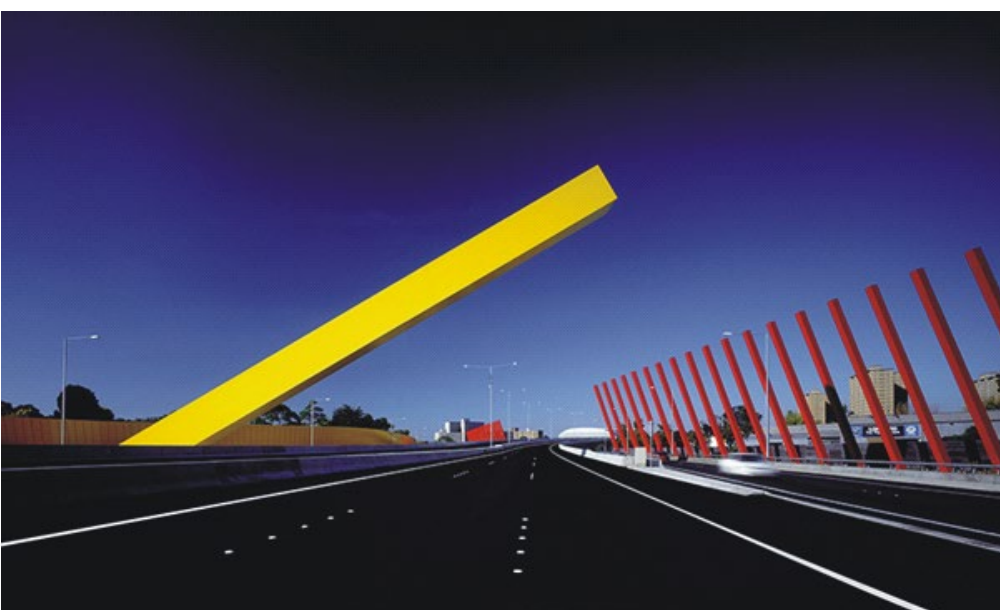
Ryc. 3. Wjazd do Melbourne w Australii prowadzący od południowo-wschodniego odcinka autostrady, zwany wejściem do Melbourne ( Melbourne Gateway ). Autor projektu: pracownia Denton Corker Marshall (fot. John Gollings) [Copyright: Denton Corker Marshall (DCM). http://www.dentoncorkermarshall.com/experiences/infrastructure-transport ]
