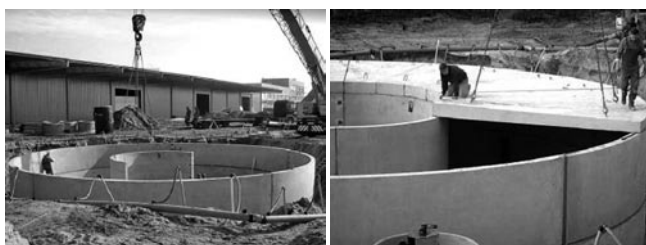
Rys. 3. Zbiornik burzowy prefabrykowany w Warszawie o pojemności 660 \text{ m}^3 [15]
