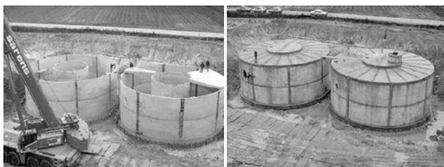
Rys. 2. Zbiorniki przeciwpożarowe w Ołtarzewie o pojemności 2 \times 1200 \text{ m}^3 [15]
