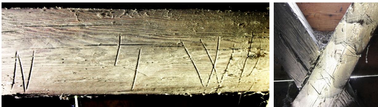
Ryc. 6. Znaki w kościele w Grodźcu, na konstrukcji więzara szczytowego – fot. M. Warchol Fig. 6. Marks in a church in Grodziec on the top truss beam of the construction – photo M. Warchol
