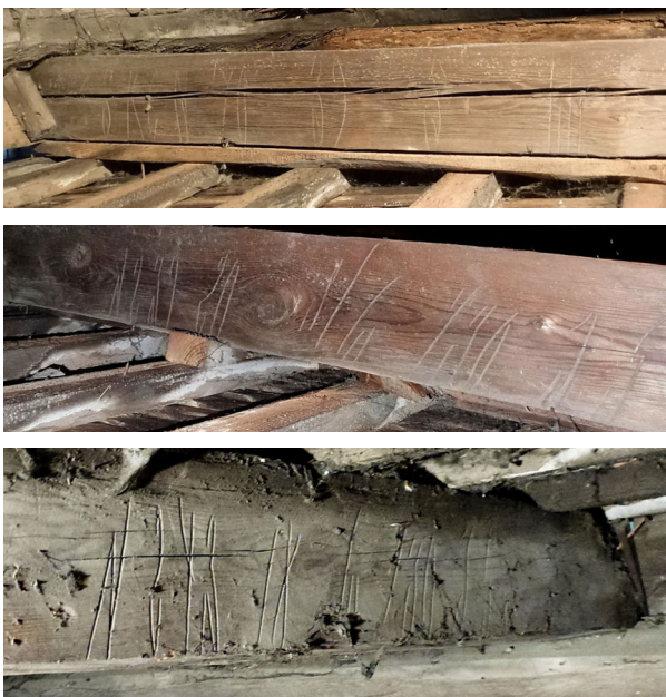
Ryc. 2. Oznaczenia na krokwiach w Kalwarii Sióstr Wizytek w Warszawie – fot. D. Sliwińska (zdjęcia obrócono w celu ułatwienia odczytania znaków)
