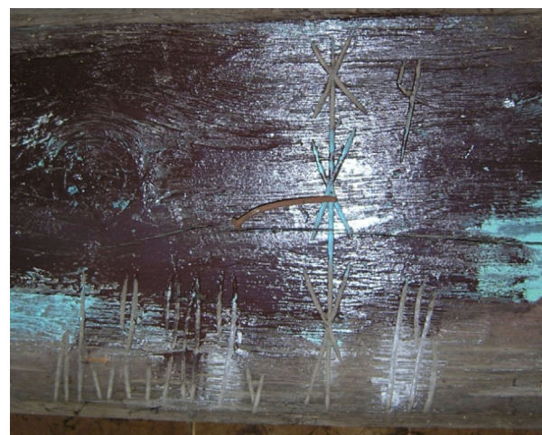
Ryc. 7. Oznaczenia na krokwiach w domach mieszkalnych 21A i D przy ul. 3 Maja w Gdańsku – fot. M. Jedlikowska Fig. 7. Signs on the rafters in tenant houses at 3 rd of May Street in Gdansk – photo M. Jedlikowska
