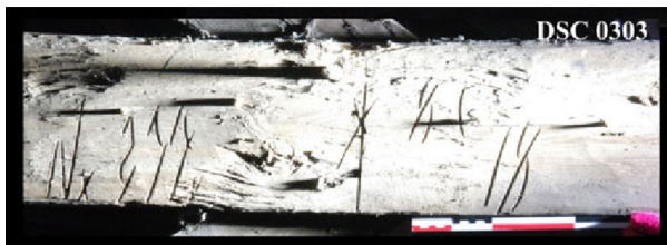
Ryc. 9. Znak handlowy na konstrukcji więźby dachowej z poł. XIX w. w kamienicy w Brukseli (fot. ©MRBC-DMS; CEA/ULg; KIK-IRPA) Fig. 9 Commercial sign on the roof frame of middle 19 th c. tenant house in Brussels (photo: ©MRBC-DMS; CEA/ULg; KIK-IRPA)
