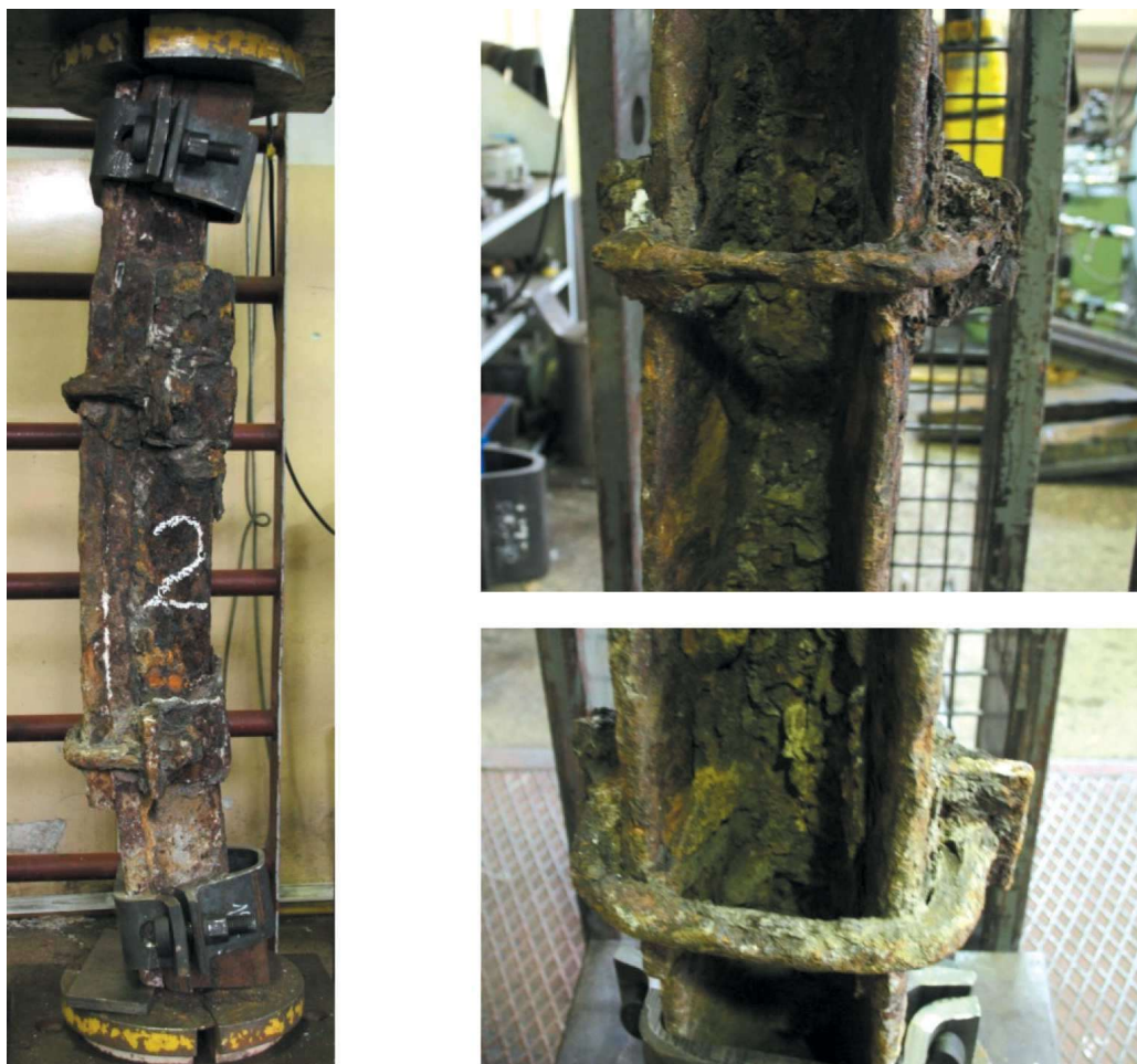
Rys. 4. Złącze cierne 2 przygotowane do badań i stan techniczny strzemiön
