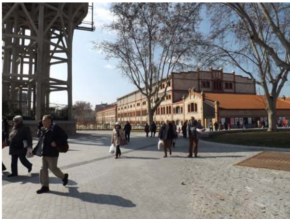
Ryc. 11. Wejście do zespołu Matadero od strony Plaza Legazpi – fot. autor (luty 2017)
