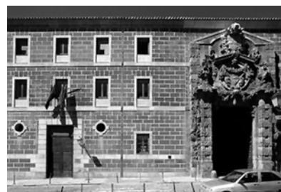
Ryc. 2. Conde Duque przed ostatnią renowacją, widoczne XIX-wieczne dekoracje ścian – źródło: www.madridhistorico.com – dostęp: 8.03.2017
