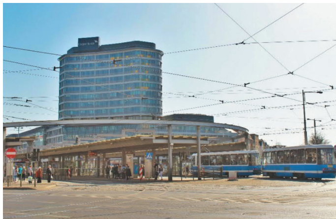
Fot. 1. Multimodalny węzeł Plac Grunwaldzki
