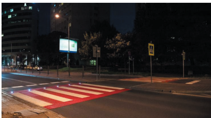
Fot. 2. Przykład aktywnego przejścia dla pieszych
