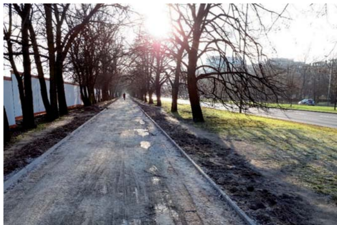
Fot. 2. Nowa ścieżka rowerowa z widocznymi przedeptami wzdłuż pni drzew. Autor: Karolina Góźdz, styczeń 2018
