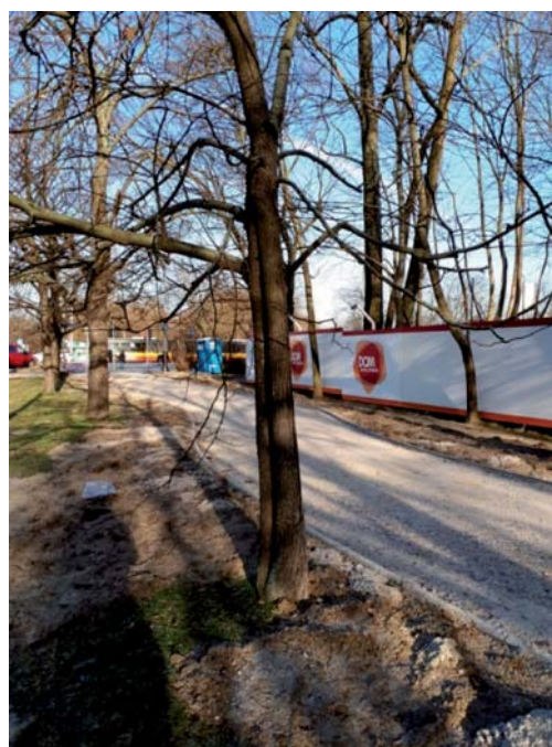
Fot. 3. Standardowa ścieżka rowerowa w bezpośrednim sąsiedztwie drzew pomnikowych powodująca uszkodzenie korzeni i zagęszczenie gleby w systemie korzeniowym drzew. Autor: Karolina Góźdz, styczeń 2018
