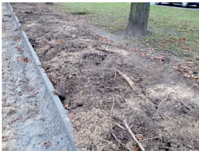
Fot. 1. Zniszczone w wyniku korytowania pod nawierzchnią korzenie drzew pomnikowych. Autor: Karolina Góźdz, listopad 2017
