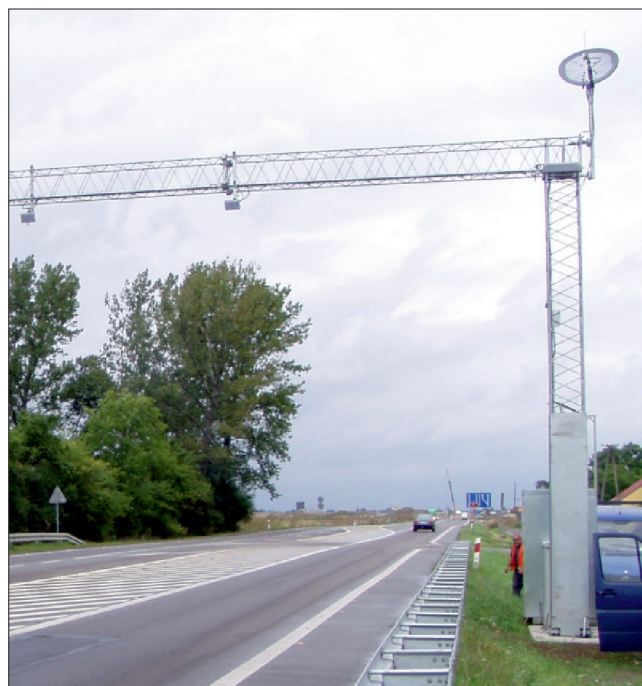
Fot. 7. Słup chroniony barierą energochłonną (źródło: Internet)
