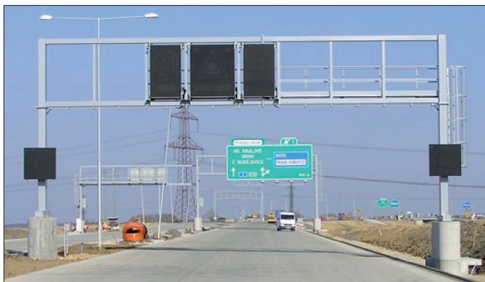
Fot. 9. Wysokie cokoly fundamentowe chroniące słupy (źródło: Internet)
