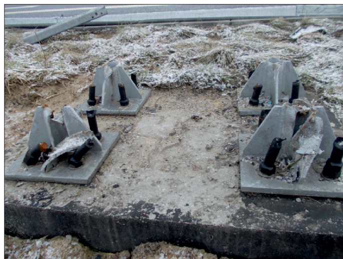
Fot. 12. Ścięty słup kratowy (fot. Krzysztof Konecki)
