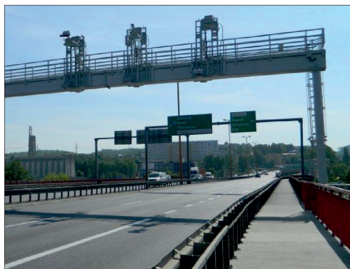
Fot. 8. Słup zamontowany poza zasięgiem uderzeń (źródło: Internet)
