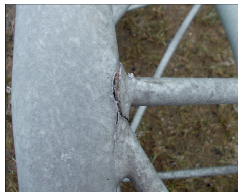
Fot. 4. Kruche pęknięcia cienkich ścianek (fot. Krzysztof Konecki)
