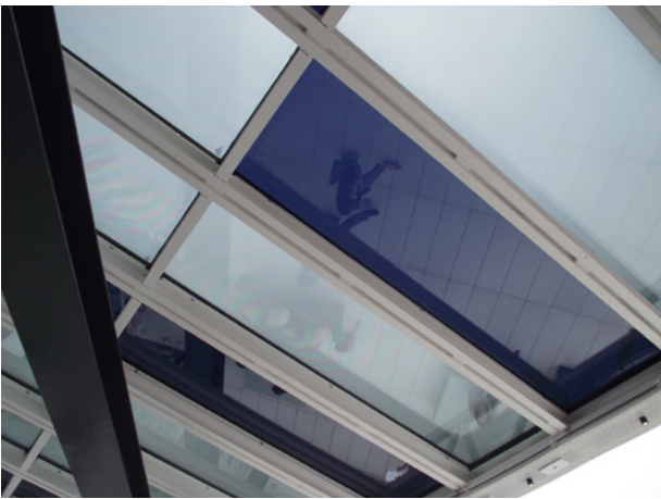
Ryc. 3. Inne materiały: 3.1. Pawilon chiński – zastosowanie ceramicznych, geometrycznych paneli samoczyszczących; 3.2. Pawilon włoski – na elewacji okładzina z oczyszczającą atmosferę betonu; 3.3. Pawilon amerykański – szklane zadaszenie pełniące rolę żaluzji zmieniających kolor; źródło: fot. autorka Fig. 3. Other materials: 3.1. Chinese pavilion - use ceramic, geometric panels self-cleaning; 3.2. Italian Pavilion - for the facade cladding of purifying the atmosphere of concrete; 3.3. American Pavilion - glass roof to act as shutters changing color; source: photo by the author
