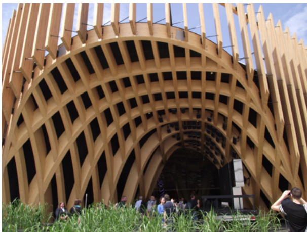
Ryc. 2. Materiał budowlany najczęściej stosowany w konstrukcji, na elewacji jako dekoracja – drewno: 2.1. Pawilon polski – zastosowanie drewna jako symbolu (skrzynka na jabłko), ozdoby; 2.2. Szczegół elewacji wykończonej sklejką pawilonu KiP; 2.3. Pawilon francuski – drewniana kratownica przestrzenna, funkcja konstrukcyjna i ozdobna; źródło: fot. autorka Fig. 2. The building material most commonly used in construction, on the facade as decoration – wood: 2.1. Polish pavilion accelerate wood (box of apples) as a symbol, ornaments; 2.2. Detail of the facade of finished plywood, KiP pavilion; 2.3. French pavilion - wooden truss spatial, structural and decorative function; source: photo by the author
