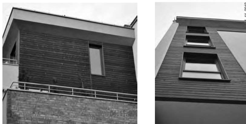
Rys. 8. Elewacja ściany tarasu oraz elewacja główna kamienicy przy ul. Jasnogórskiej (fot. autorki)
