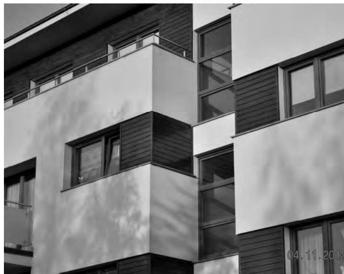
Rys. 5. Elewacja główna budynku wielorodzinnego przy ul. Bialskiej w Częstochowie (fot. autorki)
