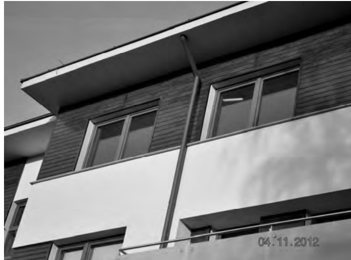
Rys. 4. Elewacja budynku wielorodzinnego przy ul. Bialskiej w Częstochowie (część górna), (fot. autorki)
