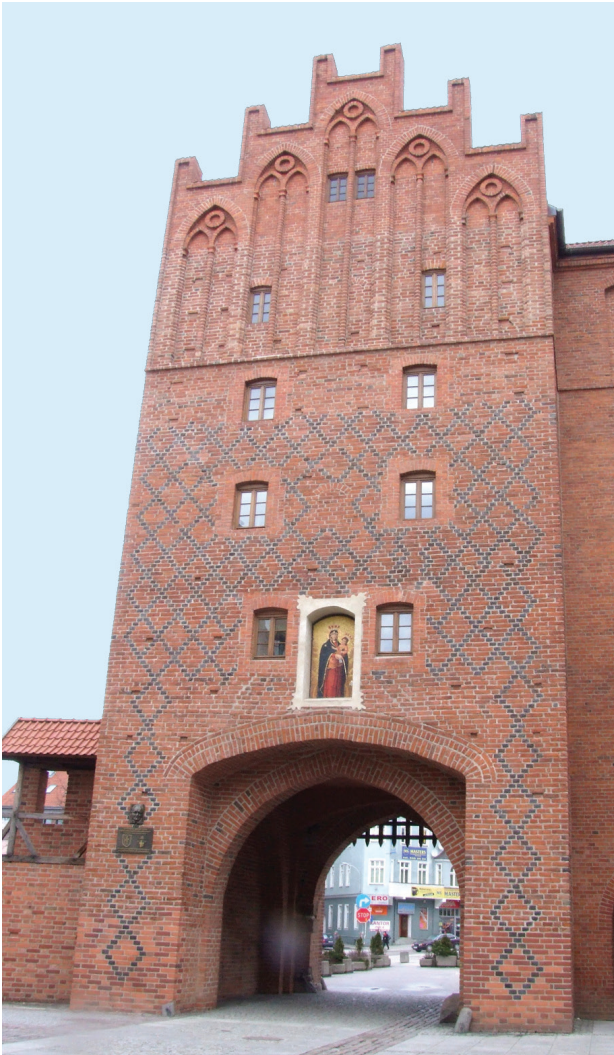
Il. 4. Wieża Wysokiej Bramy od strony Starego Miasta. W 2005 r. przeprowadzono powierzchniową konserwację jej murów, w przejeździe zamontowano bronę, a do niszy nad przejazdem powrócił wizerunek Matki Bożej z Dzieciątkiem osadzony w tym miejscu w XVIII w. (fot. M.L. Lewicka)
