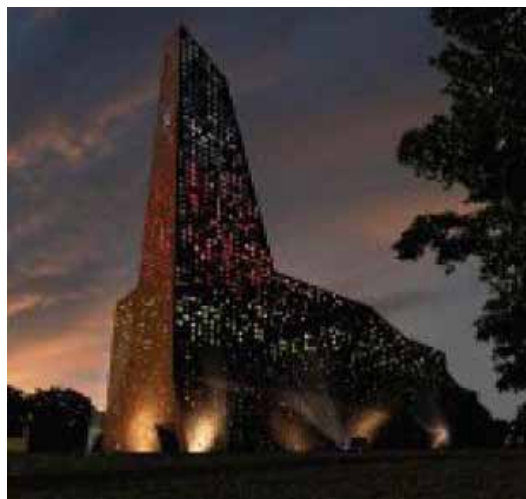
Rys. 9. Spalarnia budowana w Danii
