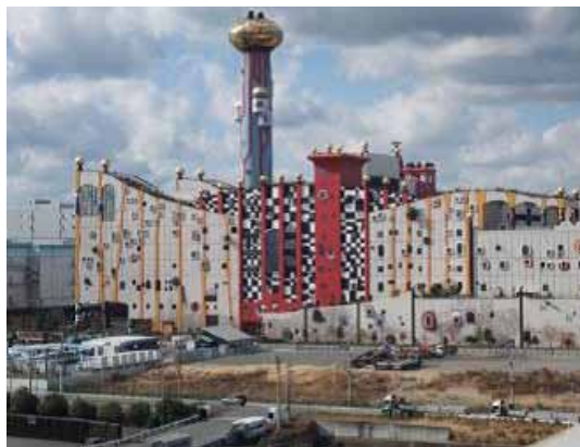
Rys.1 Widok spalarni odpadów komunalnych w Osace
