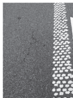
Rys. 3. Spękania zmęczeniowe poza obszarem uskoku (fot. M. Grygierek)
