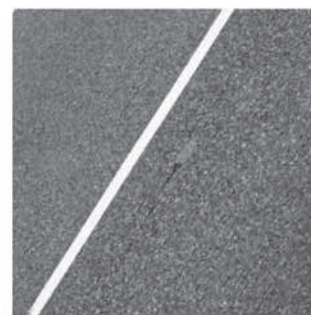
Rys. 3. Spękania zmęczeniowe poza obszarem uskoku (fot. M. Grygierek)
