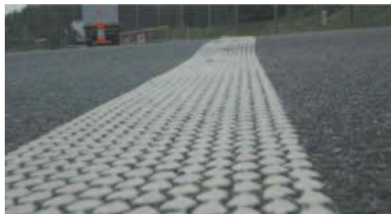
Rys. 2. Próg wzdłuż linii krawędziowej (Grygierek M.)
