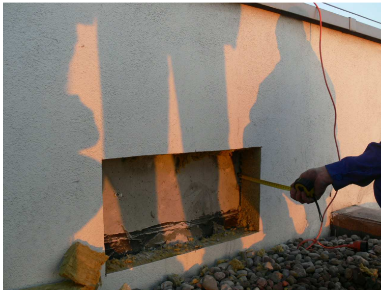
Rys. 1. Widok odkrywki ocieplenia typu ETICS wykonanego na ścianie wielokondygnacyjnego budynku mieszkalnego. Materiał termoizolacyjny – wełna mineralna
