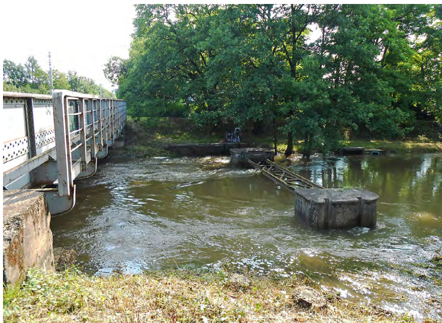
Ryc. 4. Jaz forteczny nr XI na rzece Ślęzy, 100 cm pow. stanu alarmowego (300 cm), przepływ 38 m 3 /s, 29.06.2013. (fot. Ł. Pardela)
