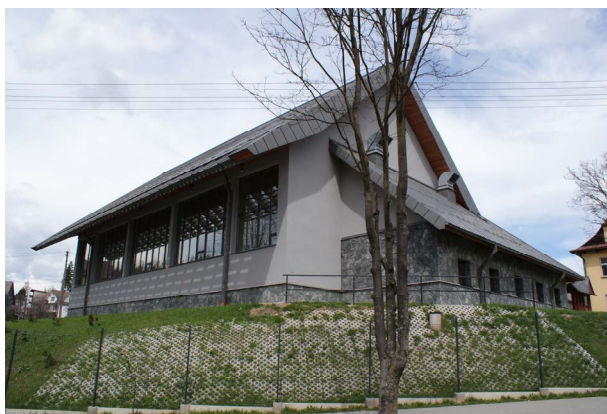
Fot. 3. Widok hali sportowej przy budynku Zespołu Szkół Ekonomicznych w Nowym Targu od strony południowej, fot. M. Krupa, 04.2012
