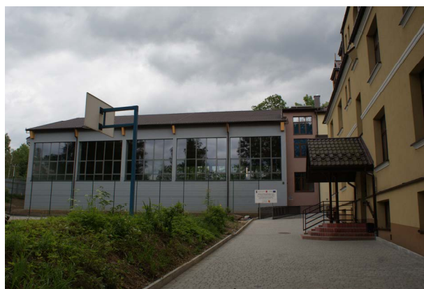
Fot. 5. Widok hali sportowej przy budynku L.O. im. E. Romera w Rabce-Zdroju od strony zachodniej, fot. M. Krupa 06.2010
