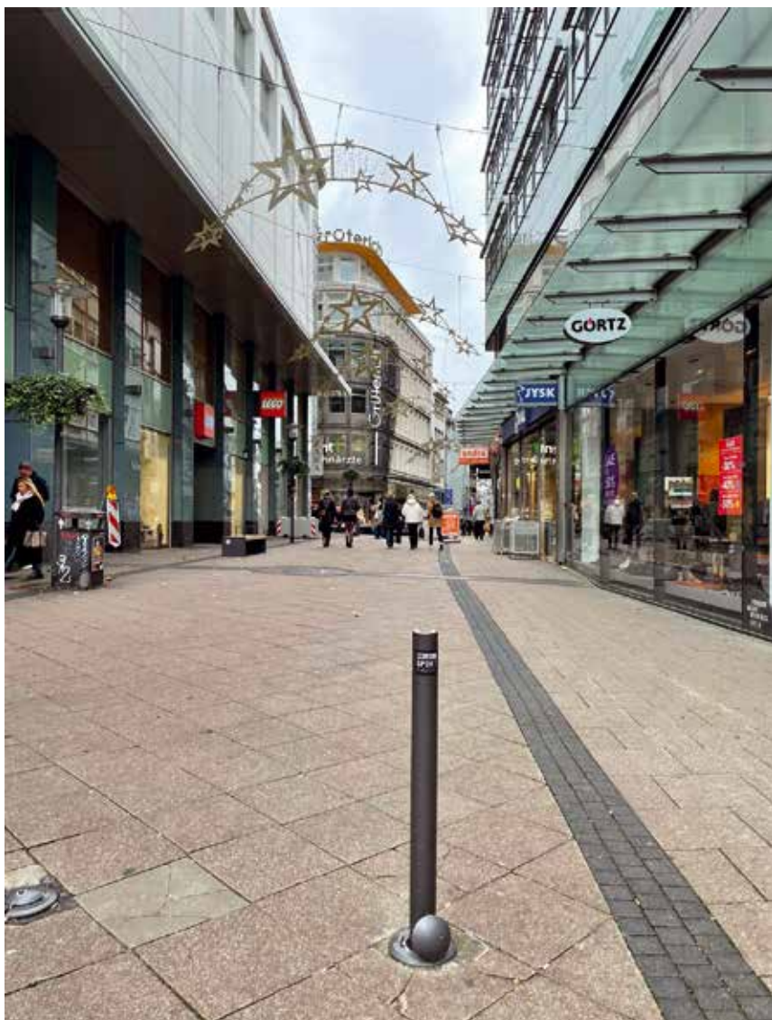
Rys. 2. Wysuwane z posadzki metalowe słupki ograniczające wjazd samochodom osobowym; źródło: fot. autora
