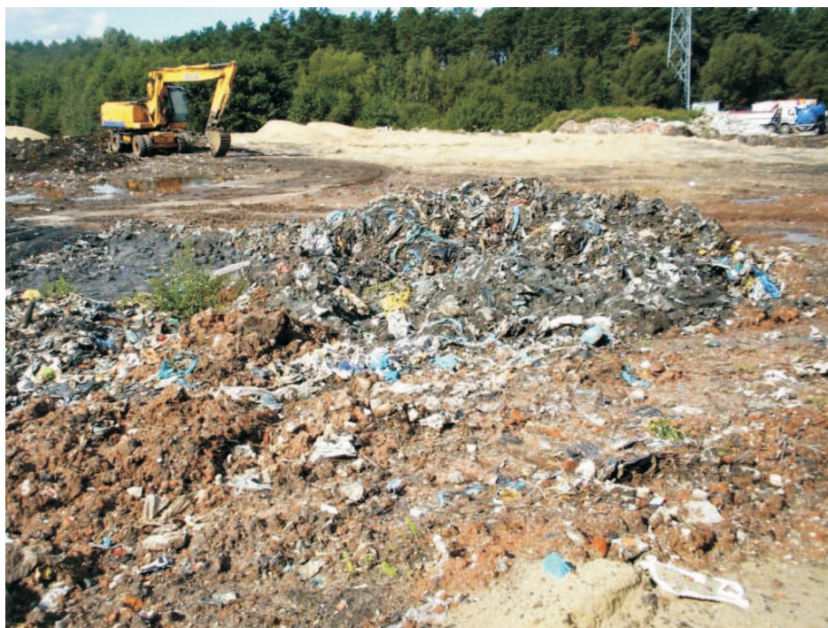
Rys. 5. Rekultywacja składowiska odpadów z użyciem odpadów wiertniczych (fot. A. Starzycka)
