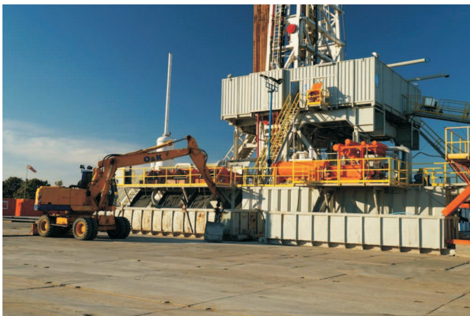
Rys. 2. Instalacja do oczyszczania płuczki na wiertni (fot. A. Starzycka)
