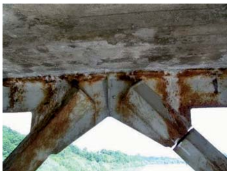
Rys. 5. Przykłady uszkodzeń obiektów użytkowanych od kilkudziesięciu lat: a) zniszczenia powłoki antykorozyjnej i korozji pomostu – ocena 2, b) pęknięcia krzyżulca mostu kratownicowego z jazdą górą – ocena 1
