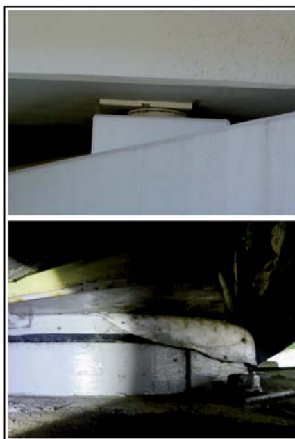
Rys. 4. Przykłady uszkodzeń łożysk z komentarzem, kodami uszkodzeń i oceną
