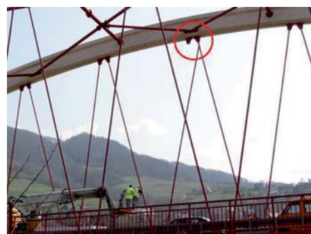
Rys. 6. Przykłady uszkodzeń nowo wybudowanych obiektów: a) wadliwe odowdnienie i zastoisko wody w konstrukcji skrzynkowej - ocena 1, b) pęknięcie wieszaka w moście łukowym – ocena 1
