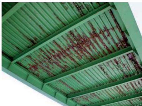
Rys. 5. Przykłady uszkodzeń obiektów użytkowanych od kilkudziesięciu lat: a) zniszczenia powłoki antykorozyjnej i korozji pomostu – ocena 2, b) pęknięcia krzyżulca mostu kratownicowego z jazdą górą – ocena 1
