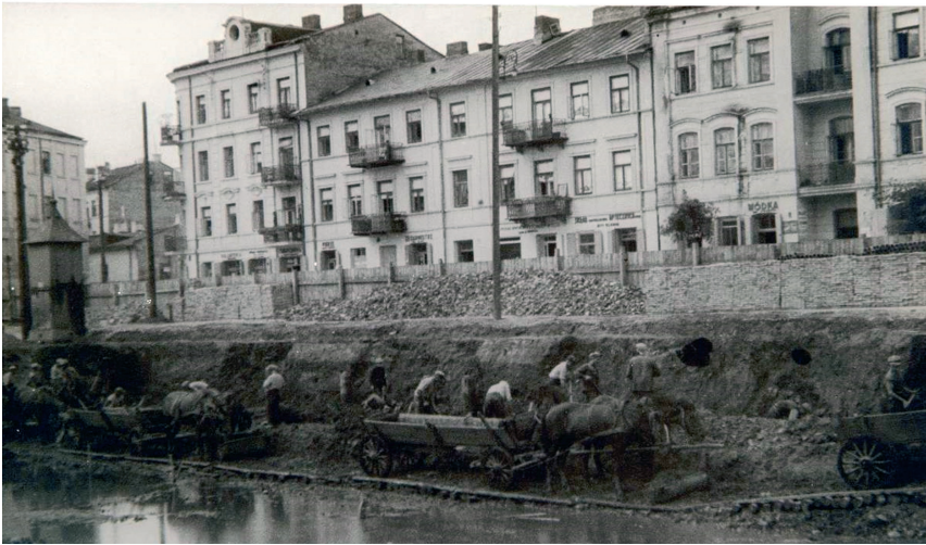
Rys. 2. Fotografie z realizacji budowy: wykop pod budynek z transportem gruntu furmankami (w dnie wykopu widoczna woda gruntowa na głębokości ok. 3 m) i wykonanie stropu nad piwnicą [2]
