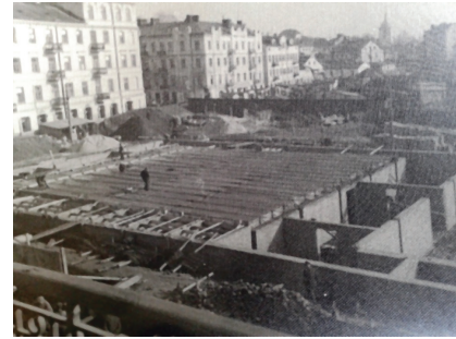
Rys. 2. Fotografie z realizacji budowy: wykop pod budynek z transportem gruntu furmankami (w dnie wykopu widoczna woda gruntowa na głębokości ok. 3 m) i wykonanie stropu nad piwnicą [2]
