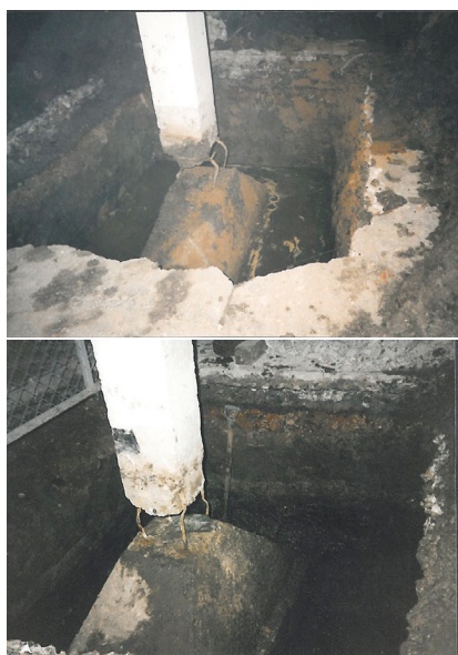
Rys. 8. Odkrytki fundamentów pod słupami wewnętrznymi [5] z widoczną wodą gruntową w wykopie
