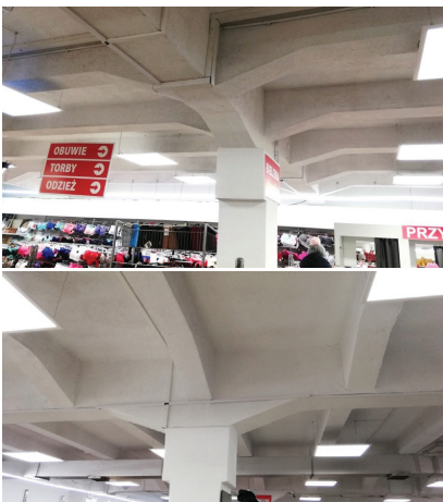
Rys. 4. Dzisiejszy widok stropu nad piwnicą (słupy z głowicami poszerzone po remoncie w 1996 r.)
